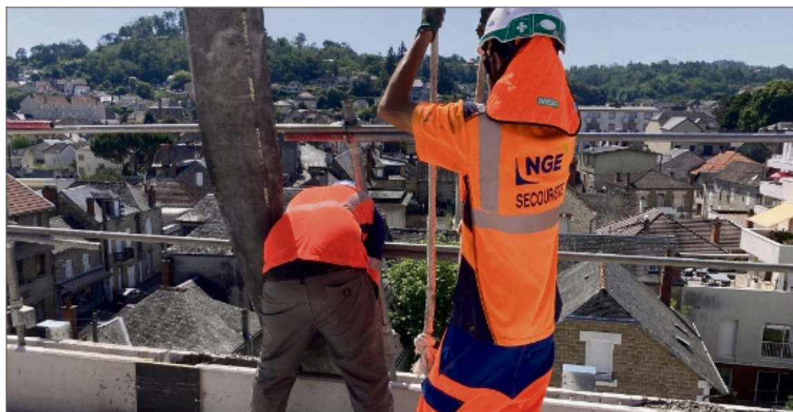
CANICULE. Hier à Brive, vers 10 heures, il faisait déjà 28 ° sur ce chantier et la saharienne fixée au casque s'avère bien utile. PHOTO P. MOUEZA
