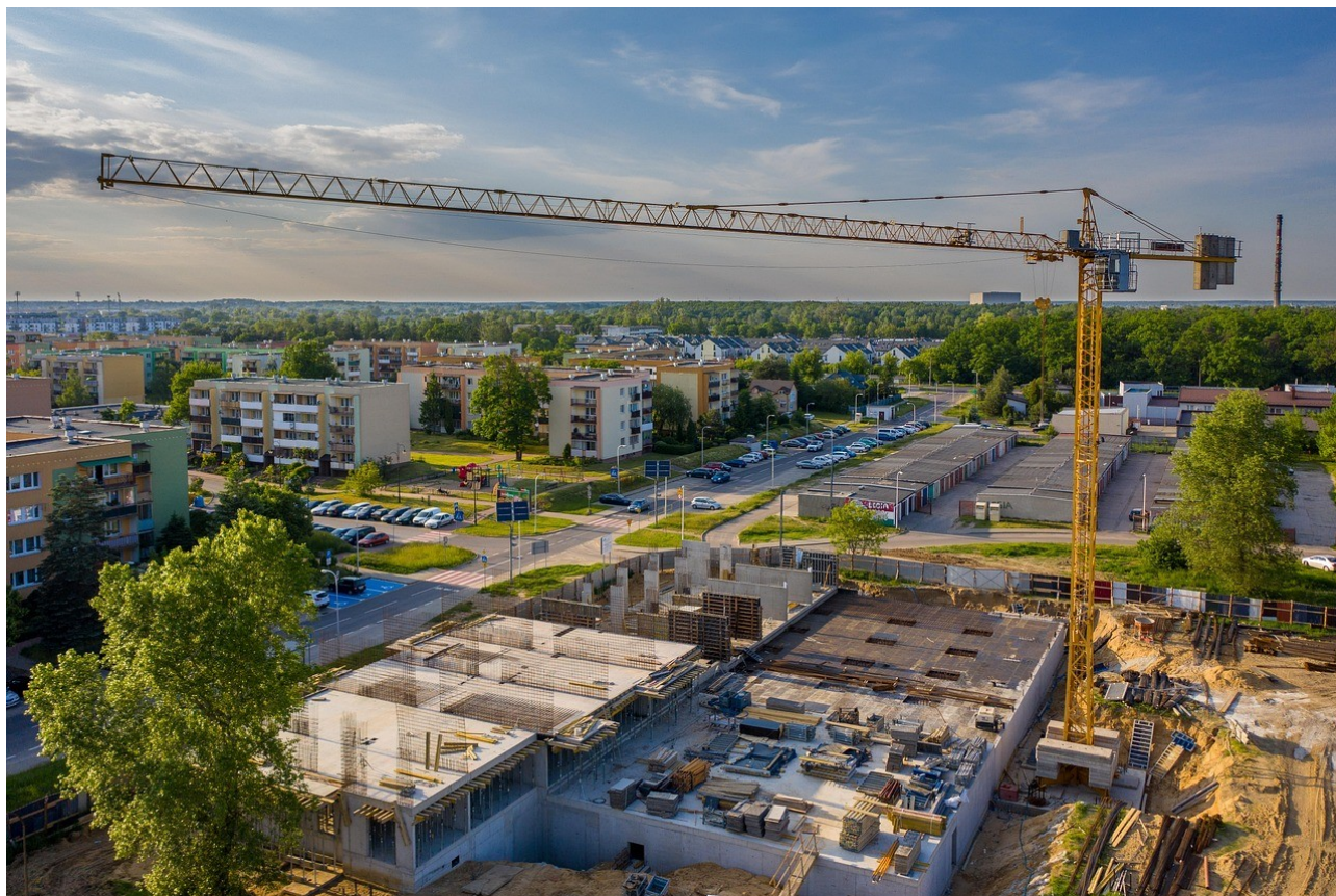
Chantier de construction. © PiotrZakrzewski / Pixabay
