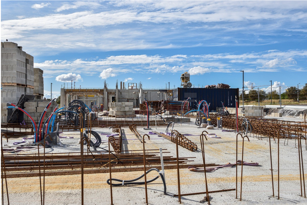
Chantier de construction d'un bâtiment en béton. © Pixabay / Mrdidg.
